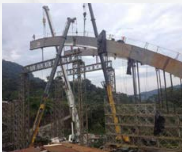
Figura 7. Montaje de las dovelas de los arcos puente Reventador, 2014 (Hidalgo 2015).
