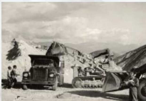
Figura 2. Construcción de la Carretera Riobamba–Cajabamba en 1961 (CEE 2024).
