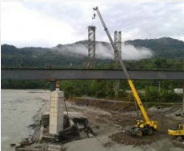
Figura 5. Puentes en el río Aguarico de 275m, 2015 (Hidalgo 2015).
