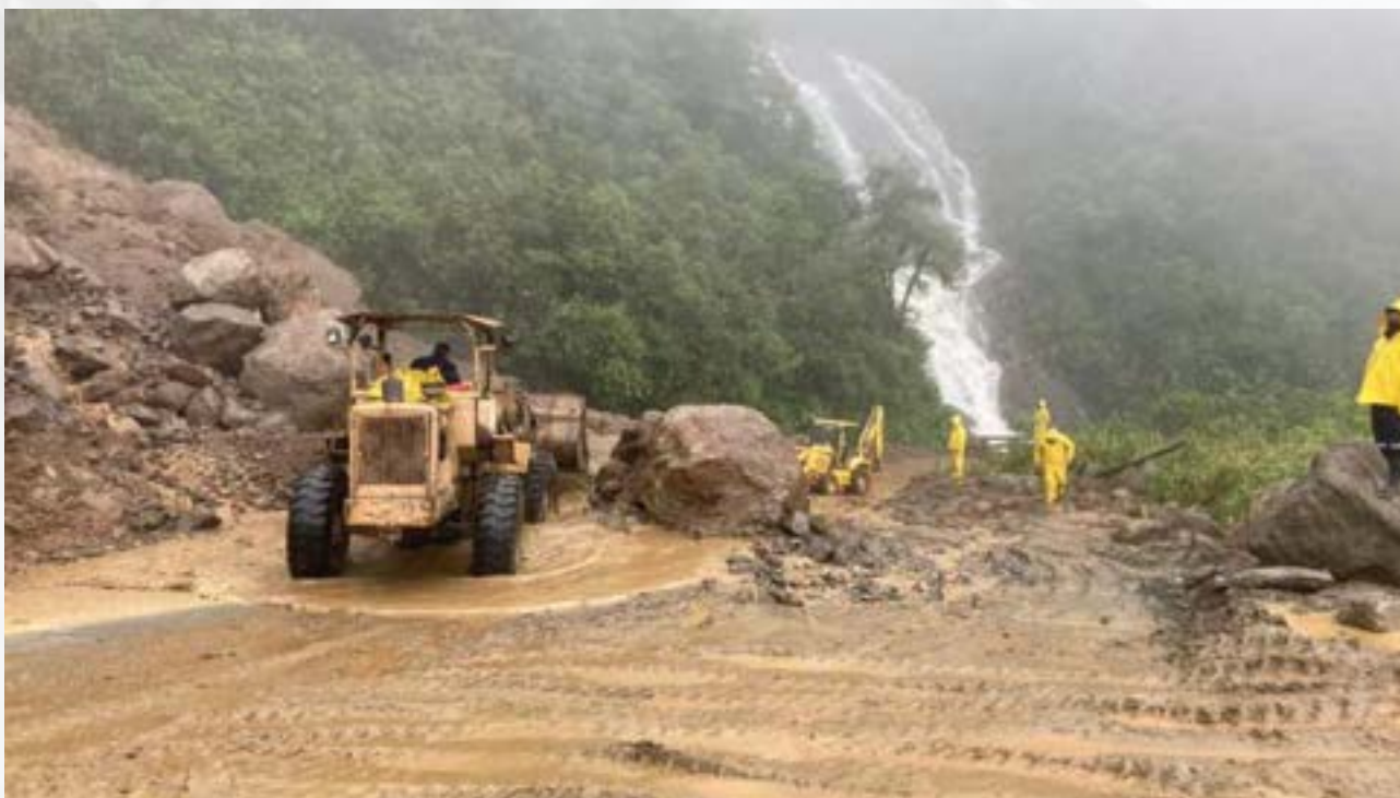
Figura 5. Apoyo de las Fuerzas Armadas durante impactos del fenómeno El Niño, (a) rescate de los afectados en Cumandá (Diario Extra), (b) deslizamientos de tierra en Alausí (Diario El Universo), (c) socavón en vía a la Concordia (Ecuavisa) y (d) deslizamiento de tierra en vía Azuay (Ecuavisa).
