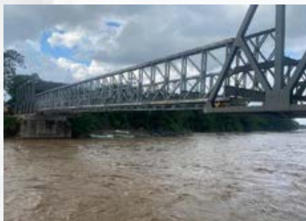
Figura 13. Puente del río Blanco, 2023 (Morales 2023).
