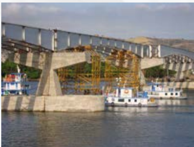
Figura 11. Montaje de las vigas del puente sobre el río Esmeraldas (Romo 2020).
