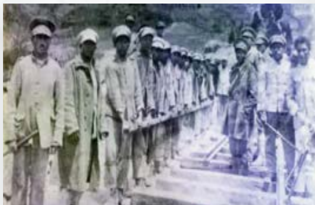
Figura 1. Batallón de Ingenieros No 67 "Montufar", trabajos en el ferrocarril Sibambe–Cuenca (Bravo 2022).
