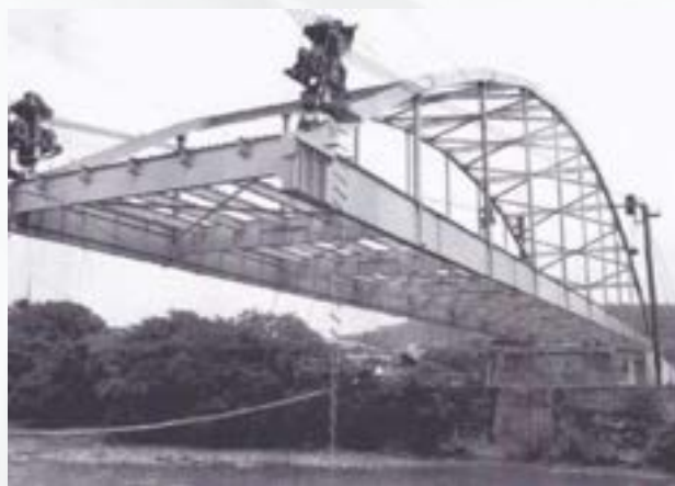
Figura 6. Puentes en el río Tena de 80.50m, 2004.
